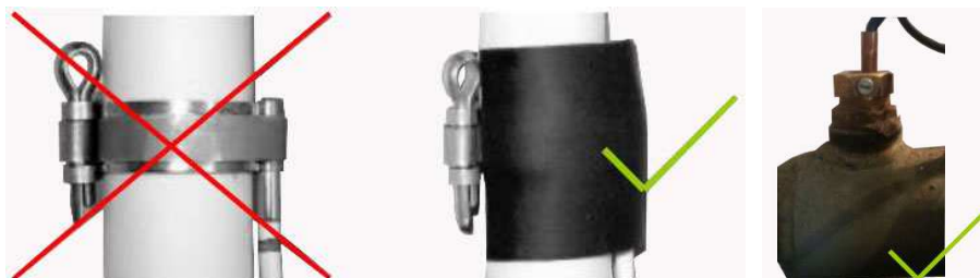
Obr. č. 8 – zapojení teplotních čidel
